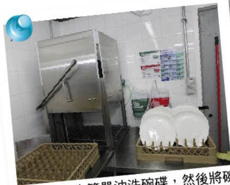
員工只需先簡單沖洗碗碟，然後將碗碟放於碗碟籃內，再將碗碟籃放入揭門式洗碗碟機，一分鐘後便完成洗碗工序，極位節能
