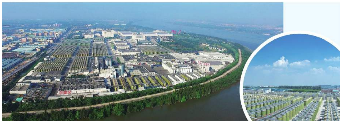
▲▶ 李錦記在世界各地的廠房推行節能減廢及循環再用的措施。2015年更推行綠色生產，於新會生產基地設立光伏發電設備及地源熱泵系統。
